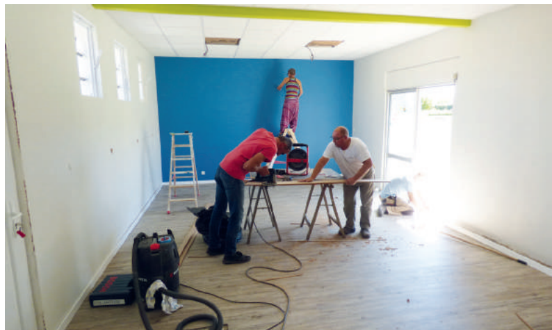
Le personnel de l'IEPR en train de réaliser les travaux de rénovation.
