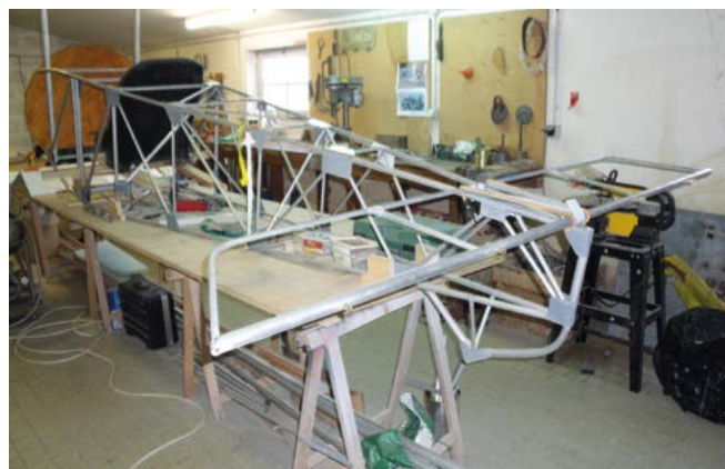
La structure métallique du Nieuport lors de sa construction
